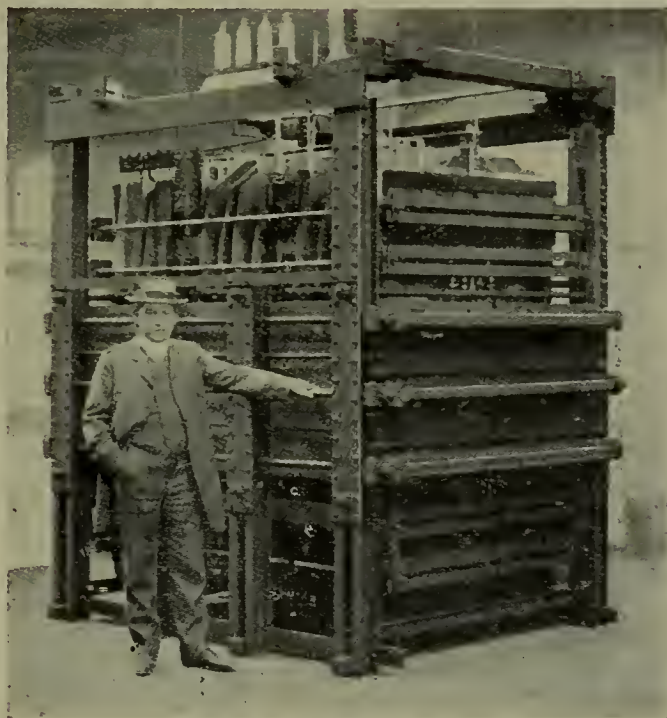
Fig. 45. - Transformateur (vue d'ensemble).
